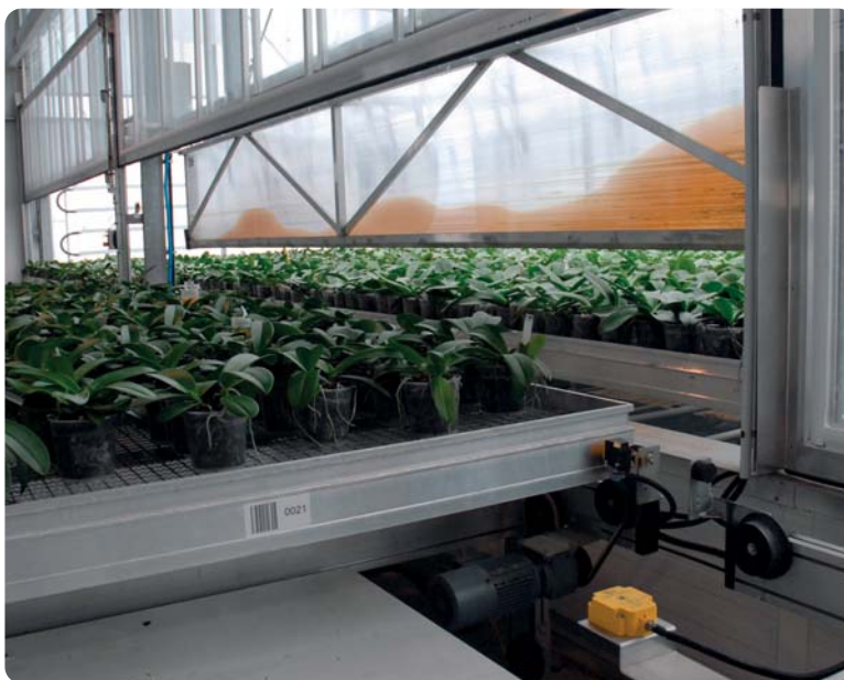
Bild 2: An der Bearbeitungsstation am Kopf der Halle erfassen Q80-RFID-Schreibleseköpfe (unten rechts) das darüber fahrende Rollbeet, das mit einem R30-Datenträger an der Unterseite gekennzeichnet ist.
